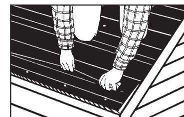
Étape 5 – Installer soit un feutre (climats chauds) ou une sous-couche d'étanchéisation de bardeaux WinterGuard™ (climat froid) sur la prise d'air Intake Vent prenant soin d'éviter de clourer dans la fente du platelage du toit. Utilisant un cordeau, transférer la ligne de clouage (67 mm [2 5/8 po] du larmier) et l'emplacement de la fente (146 à 178 mm [5 3/4 à 7 po] du larmier) au haut du feutre ou de la sous-couche d'étanchéisation des bardeaux WinterGuard™.
